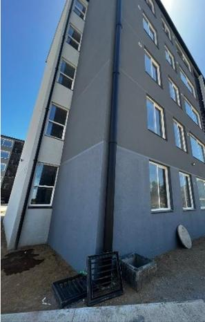
Se denomina techumbre al conjunto compuesto por la cubierta, su estructura y soluciones para la evacuación de aguas lluvias. En este caso las bajadas corresponden a ductos de PVC que conducen el agua hasta sumideros dren.
