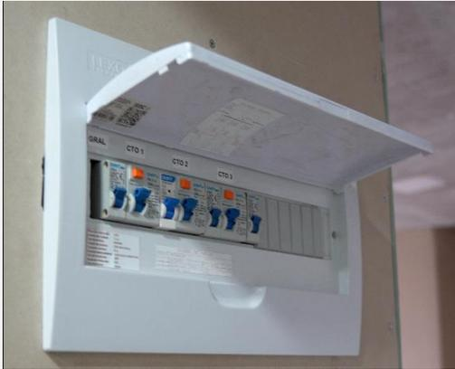
La red para el abastecimiento de energía eléctrica consta de circuitos destinados a centros de iluminación y enchufes. El funcionamiento de esta red es controlado por un tablero llamado TDA, en el que se encuentran ubicados una serie de interruptores individuales, que controlan toda la energía eléctrica del departamento, incluyendo los circuitos de iluminación y de enchufes. Además de un automático general.
