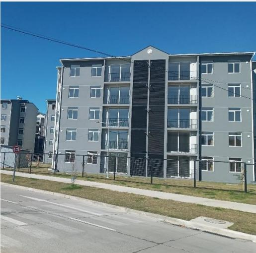
Las fachadas por otra parte forman el cierre del edificio y funcionan como aislación y protección del exterior. El sistema de aislación térmica EIFS con acabado rugoso (FINISH) no cumple función estructural, su función es estrictamente estético y térmico, por lo que **queda prohibido fijar cualquier tipo de elemento a la fachada o perforarla**, para evitar el ingreso de agua y desprendimientos, lo que provocaría daño de los acabados exteriores del condominio.
