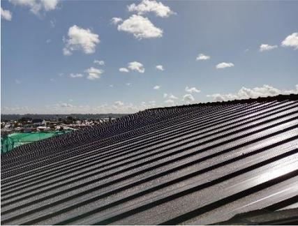
La cubierta debe mantenerse limpia, sin pasto, hojas, tierra, especialmente los sumideros y canales. La cubierta será accesible sólo para su mantención y conservación. Se debe procurar, siempre que sea posible, no pisar las cubiertas en pendiente. Cuando se transite por ellas hay que tener mucho cuidado de no producir desperfectos, en efecto se debe acceder a ella mediante la escotilla de acceso a cubierta ubicada en el
