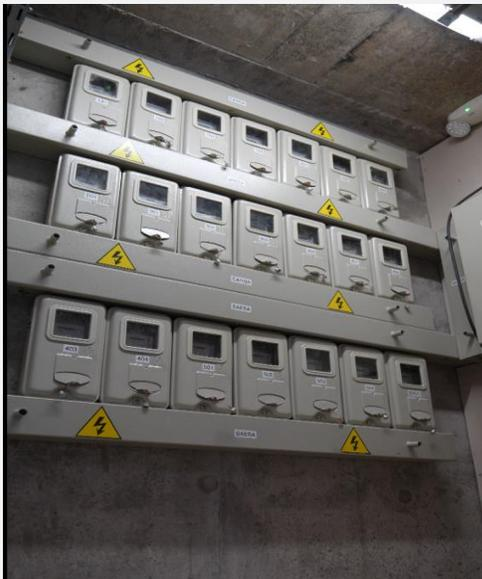
Como medida de protección a los usuarios, el sistema eléctrico está conectado a la fase “tierra” del medidor, por lo que, ante una eventual descarga eléctrica, la corriente se conduzca hacia la “malla a tierra”, lo que evitará dañar a las personas o a los artefactos eléctricos.
