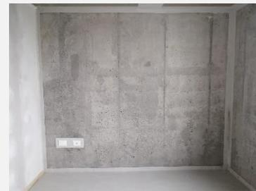
Los muros perimetrales de cada departamento, en ningún caso pueden ser modificados, ya que, si dan al exterior, afectan la fachada del edificio, lo que está prohibido en el reglamento de copropiedad, tampoco se permite modificación o alteración a muros medianeros entre departamentos o pasillos o cualquier muro estructural de hormigón. Cabe recalcar que **NO SE PUEDE CORTAR NI ELIMINAR NINGÚN ELEMENTO ESTRUCTURAL, COMO SON FUNDACIONES, MUROS, PILARES, VIGAS Y LOSAS.**
