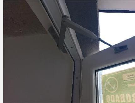
proyecto, en cada puerta de acceso a edificios se encuentra instalado un brazo hidráulico ajustado para asegurar una apertura y cierre suave, con motivo de cuidar la puerta ante golpes. En caso de desajuste del mecanismo, se requiere mantención correspondiente, para mantener en buen estado la puerta.
