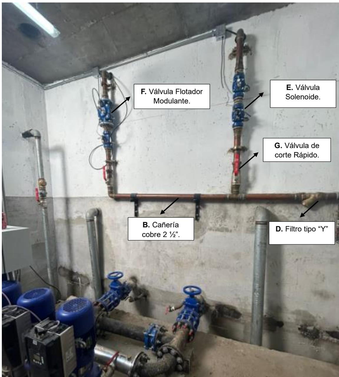
*1.4. Despiece del sistema de llenado PEAP, en sala de bombas.*
